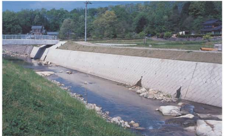
河川改修工事
